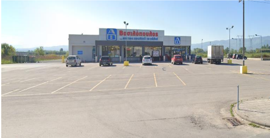
Εικόνα 24: Υφιστάμενη κατάσταση υπάρχοντος σταθμού φόρτισης Η/Ο (Πηγή: Google Street View)
