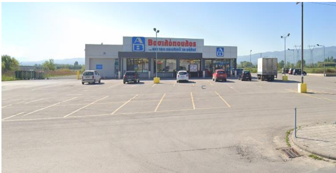
Εικόνα 21: Υφιστάμενη κατάσταση υπάρχοντος σταθμού φόρτισης Η/Ο (Πηγή: Google Street View)
